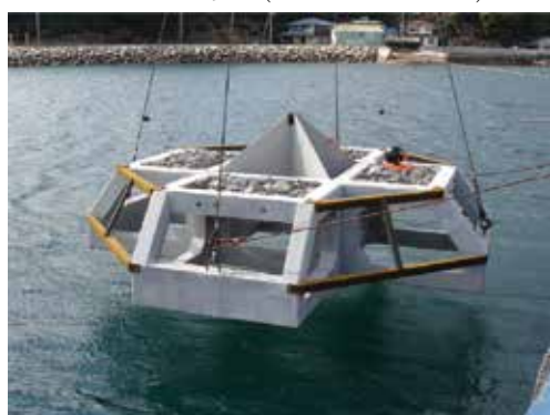
魚類の保護育成, 攪拌, 底質改善, 藻場造成, 餌料培養
