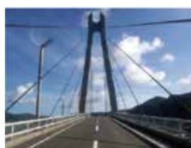
鹿児島県甌大明神橋
