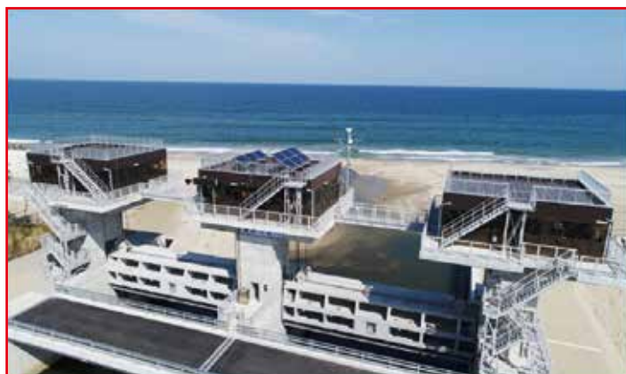
3連陸屋根タイプ 寸法：幅8.20m×奥行10.2m×高さ3.67m 重量：4,750kg
