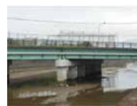
鹿児島県塩釜橋
