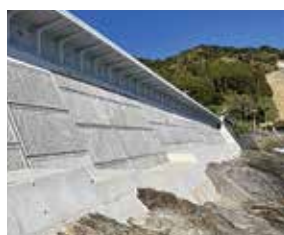
宮崎県大型擁壁
