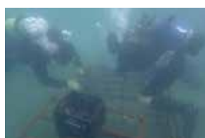
投入したパネルを海中で潜水士が組立
