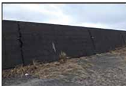
設置後44ヶ月状況 (変状無し)
