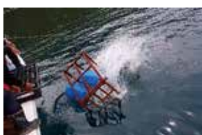
船上でパネルを組立て、人力で投入
